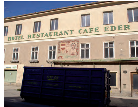
Der Container steht bereit.
